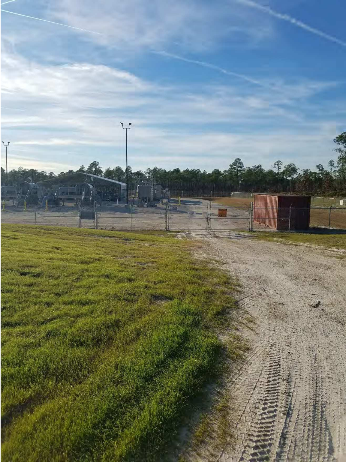
Suwannee Creek M&R: 001 (facing West)
